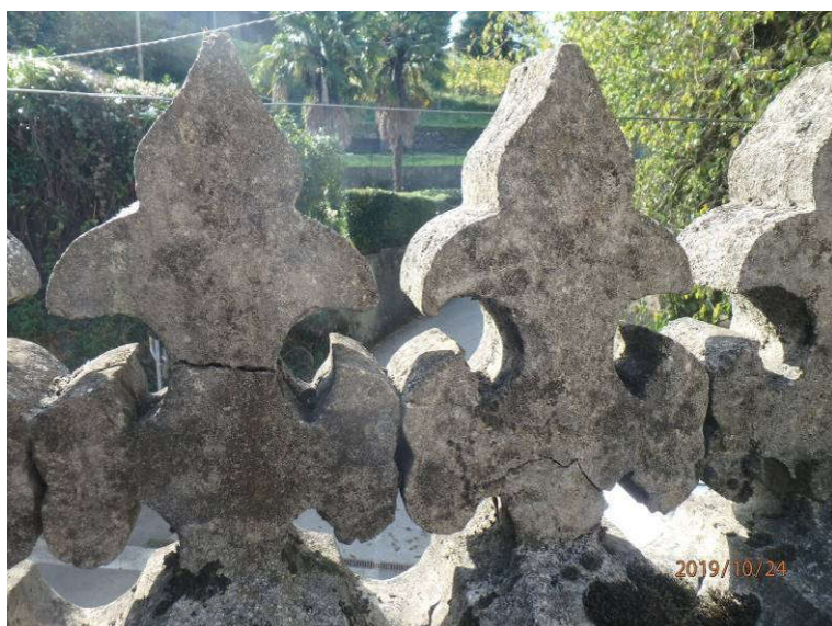
Slika 85: Vhodni objekt, poškodbe na strehi: razpadanje betona okrasnih elementov ograje
