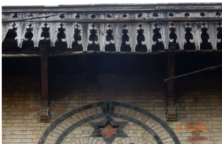
Slika 23: Poškodbe na južni fasadi: dotrajani leseni okrasni elementi napušča
