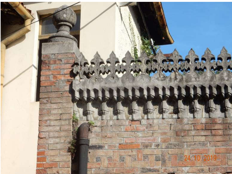
Slika 76: Vhodni objekt, poškodbe na južni fasadi: lokalne poškodbe opeke, odpadanje krovnege sloja betona in korozija armature betonske ograje
