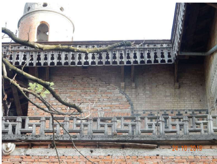
Slika 20: Poškodbe na južni fasadi: poševna razpoka od napušča navzdol, močno poškodovana betonska ograja terase (nestabilno), močno dotrajani leseni elementi napušča
