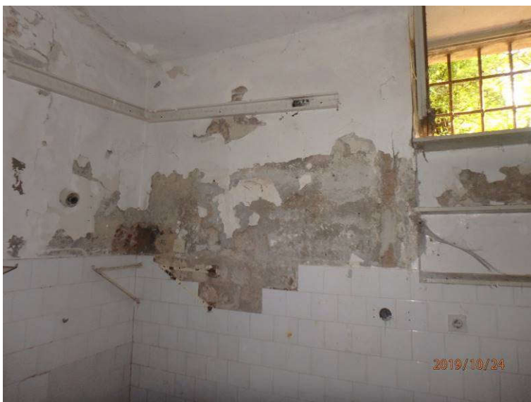
Slika 32: Poškodbe v notranjosti pritličja: odpadanje ometa, luščenje opleska in odpadanje keramičnih ploščic na stenah
