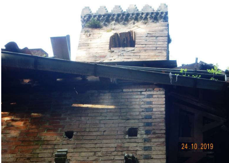
Slika 26: Poškodbe na vzhodni fasadi: lokalna porušitev napušča
