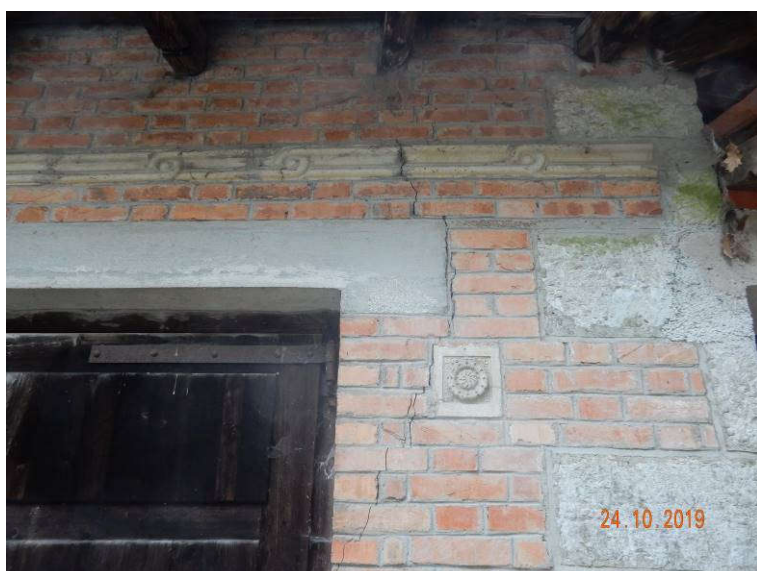
Slika 94: Garaža, poškodbe na zahodni fasadi: razpoka v območju preklade
