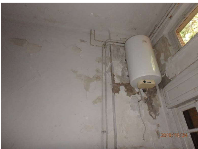
Slika 34: Poškodbe v notranjosti 1. nadstropja: odpadanje ometa in luščenje opleska na stenah
