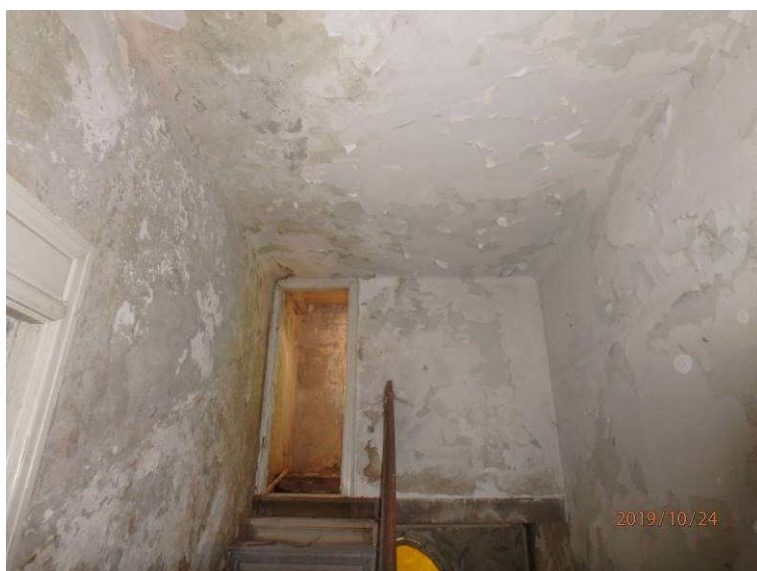
Slika 43: Poškodbe v notranjosti 2. nadstropja: močno luščenje opleska in ometa na steni severnega stopnišča
