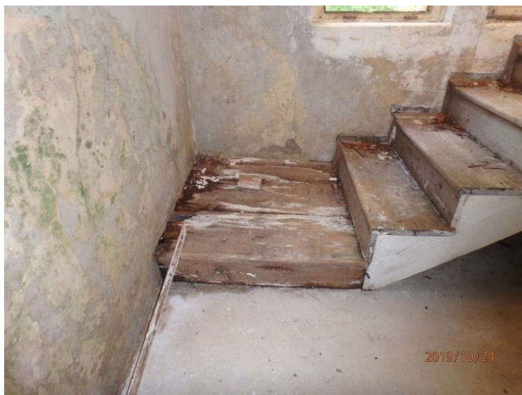
Slika 44: Poškodbe v notranjosti 2. nadstropja: dotrajane lesene stopnice na streho
