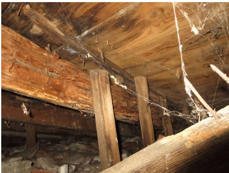
Slika 56: Poškodbe na strehi: poškodovani leseni elementi ostrešja v območju zamakanja strehe
