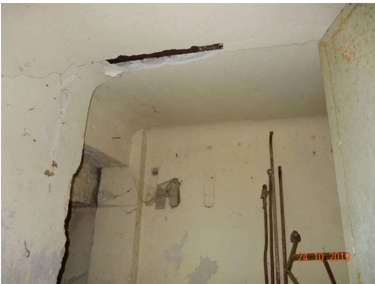
Slika 79: Vhodni objekt, poškodbe v notranjosti: razpoke, odpadanje ometa, korozija jeklenega nosilca
