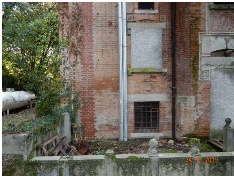
Slika 6: Poškodbe na severni fasadi: poševna razpoka ob vertikalni prezidavi, posamične poškodbe opečnih zidakov, vidni sledovi zamakanja, poškodbe na betonski okenski prekladi, pozidava okna v prvem nadstropju, poškodovani okrasni elementi betonske ograje (spredaj), poraščenost z vegetacijo
