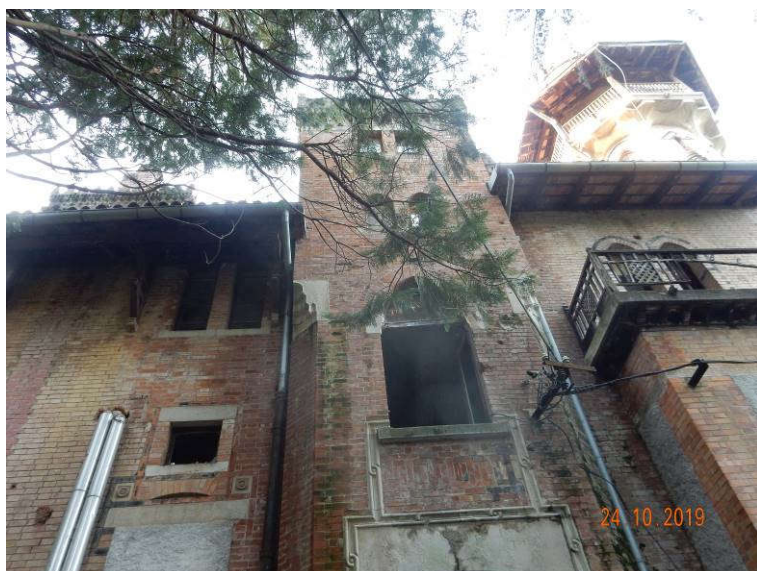
Slika 7: Poškodbe na severni fasadi: manjkajoča zasteklitev okenskih odprtin, sledovi zamakanja, povsem uničena lesena balkonska ograja
