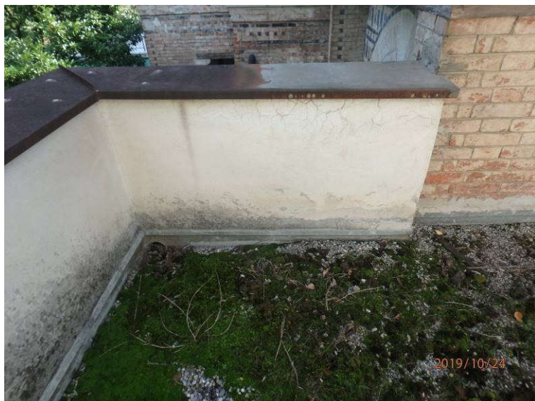
Slika 84: Vhodni objekt, poškodbe na strehi: mrežaste razpoke na ometu atike, korozija pločevinaste obrobe
