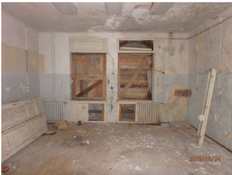
Slika 31: Poškodbe v notranjosti pritličja: odpadanje ometa in luščenje opleska na stenah in stropu
