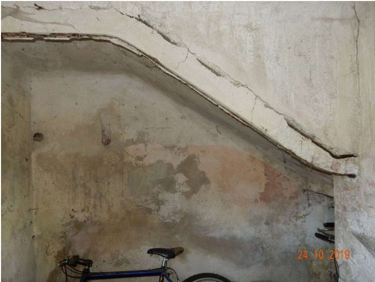
Slika 78: Vhodni objekt, poškodbe v notranjosti: razpoke med jeklenim nosilcem in stopniščno ramo, odpadanje ometa, korozija jeklenega nosilca
