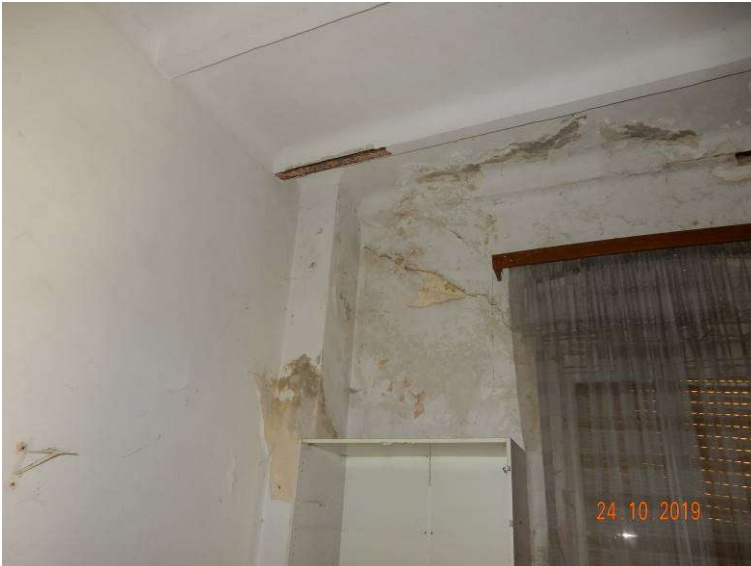
Slika 81: Vhodni objekt, poškodbe v notranjosti: odpadanje ometa, korozija jeklenega nosilca, zamakanje v območju okenske odprtine
