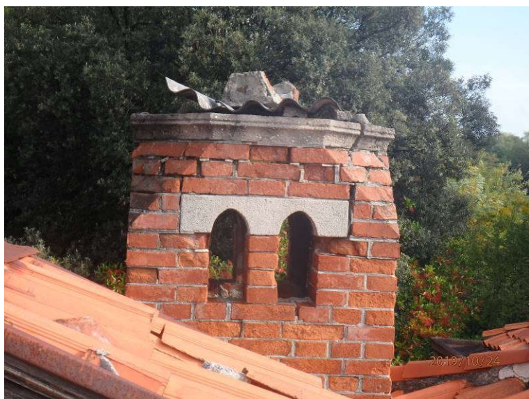
Slika 50: Poškodbe na strehi: manjka dimniška kapa, razmaknjeni zidaki
