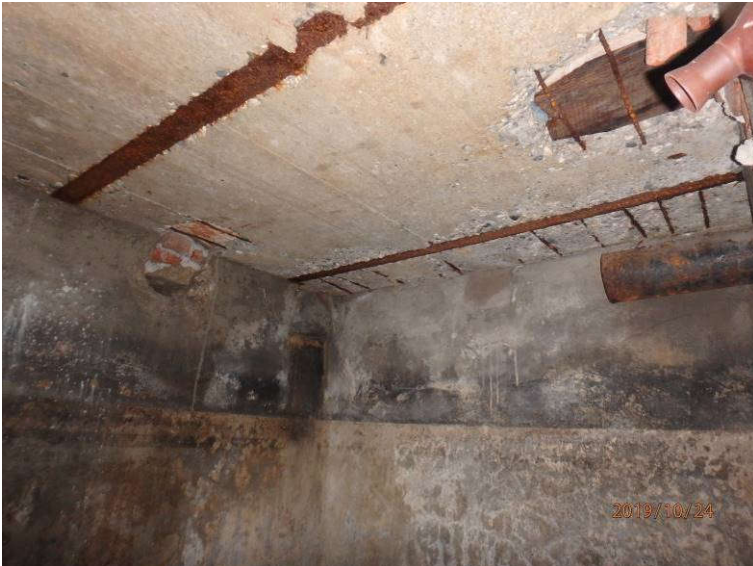
Slika 27: Poškodbe v notranjosti kleti: odpadanje krovne sloja betona in korozija jeklenih nosilcev in armaturnih palic betonske stropne plošče
