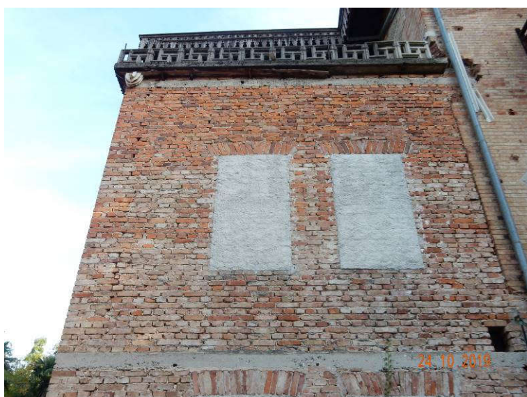
Slika 19: Poškodbe na južni fasadi: slabša kvaliteta pozidave, vertikalne razpoke (med zidaki) pozidave
