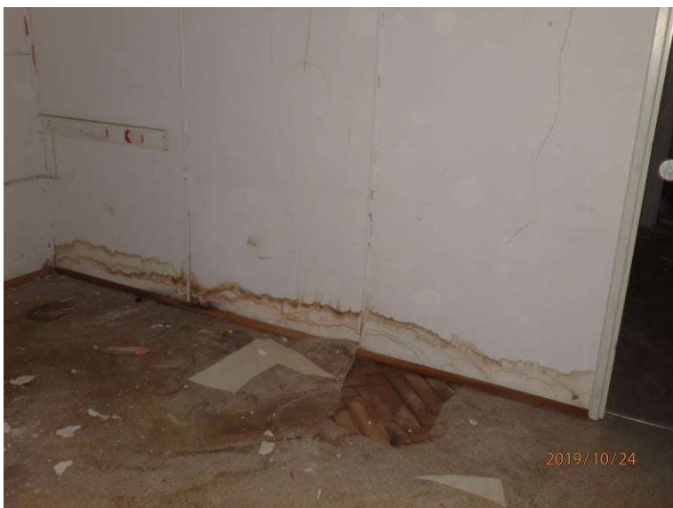
Slika 35: Poškodbe v notranjosti 1. nadstropja: sledovi zamakanja na predelni steni
