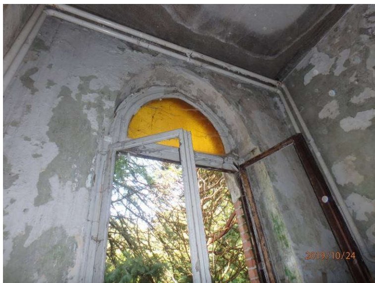
Slika 38: Poškodbe v notranjosti 1. nadstropja: odpadanje ometa in luščenje opleska na stenah in stropu v območju severnega stopnišča
