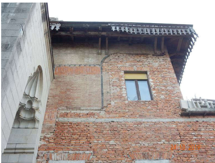
Slika 17: Poškodbe na zahodni fasadi: slabša kvaliteta pozidave, vertikalne razpoke (med zidaki) pozidave, odpadanje lesenih okrasnih elementov napušča
