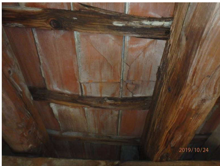
Slika 89: Vhodni objekt, poškodbe na strehi: poškodba opečne kritine, zamakanje, poškodbe lesenih elementov ostrešja
