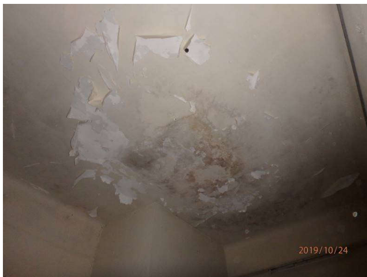
Slika 41: Poškodbe v notranjosti 2. nadstropja: luščenje opleska in sledovi zamakanja na stropu
