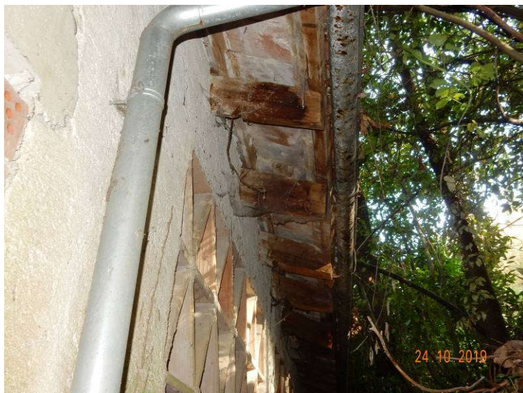
Slika 96: Garaža, poškodbe na vzhodni fasadi: dotrajani leseni elementi ostrešja, korozijske poškodbe na žlebu
