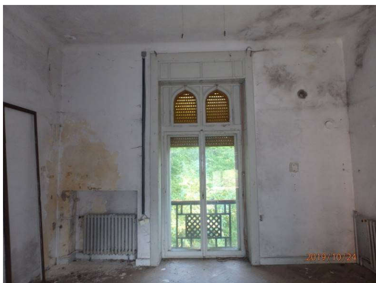
Slika 40: Poškodbe v notranjosti 2. nadstropja: luščenje opleska na steni, sledovi zamakanja na stropu
