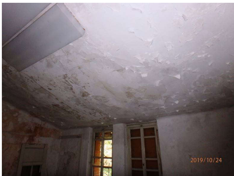
Slika 39: Poškodbe v notranjosti 2. nadstropja: luščenje opleska na stropu, sledovi zamakanja, vidno povešen strop
