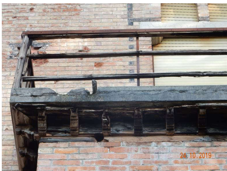
Slika 22: Poškodbe na južni fasadi: povsem dotrajana lesena balkonska ograja, poškodbe betonske plošče
