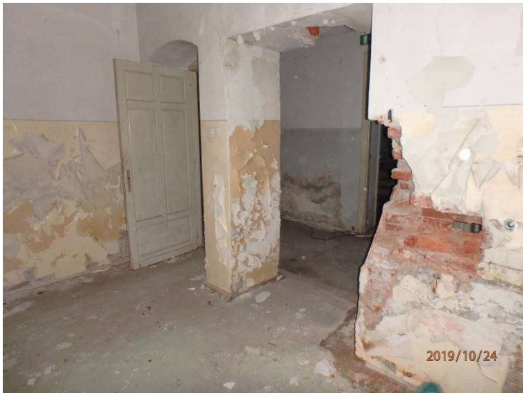
Slika 30: Poškodbe v notranjosti pritličja: odpadanje ometa in luščenje opleska na stenah, lokalne poškodbe opečnega zidu – najverjetneje posledice predhodnih preiskav
