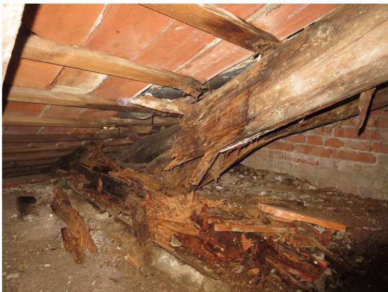
Slika 54: Poškodbe na strehi: poškodovani leseni elementi ostrešja v območju zamakanja strehe
