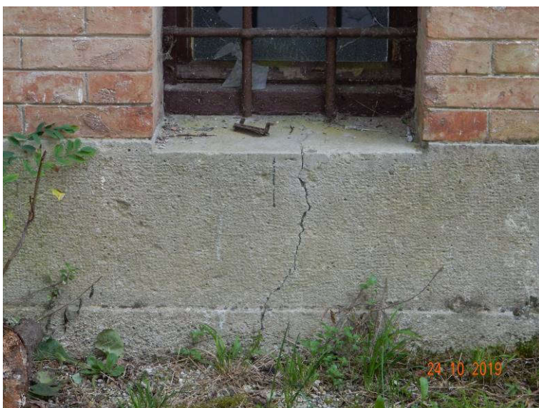
Slika 11: Poškodbe na severni fasadi: vertikalna razpoka na coku
