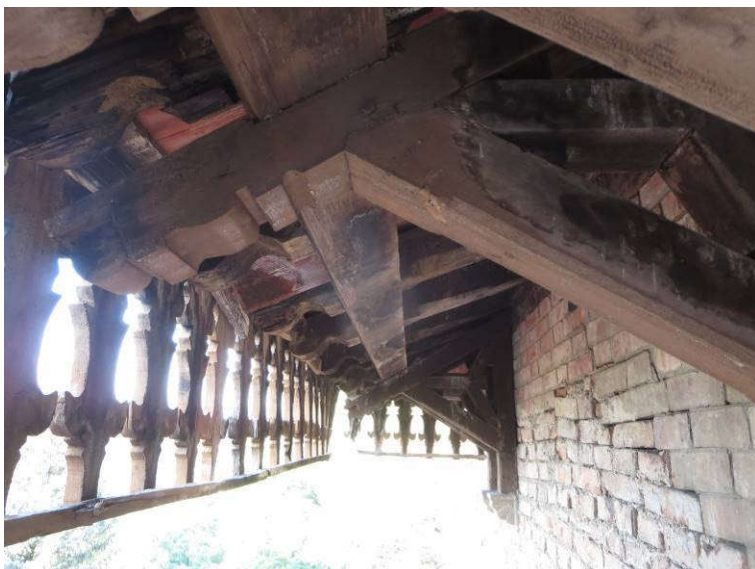
Slika 57: Poškodbe na strehi: poškodovani leseni elementi napušča (južna fasada)
