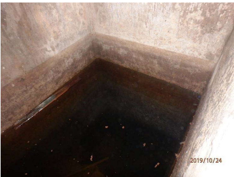
Slika 29: Poškodbe v notranjosti kleti: nižjeležeči prostori kleti (najverjetneje zbiralnik za vodo) so zapolnjeni z vodo
