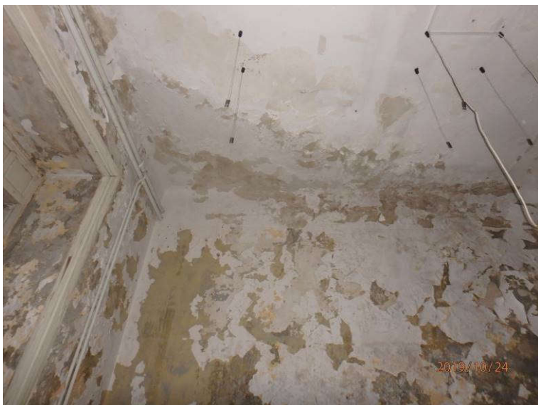
Slika 33: Poškodbe v notranjosti 1. nadstropja: odpadanje ometa in luščenje opleska na stenah in stropu
