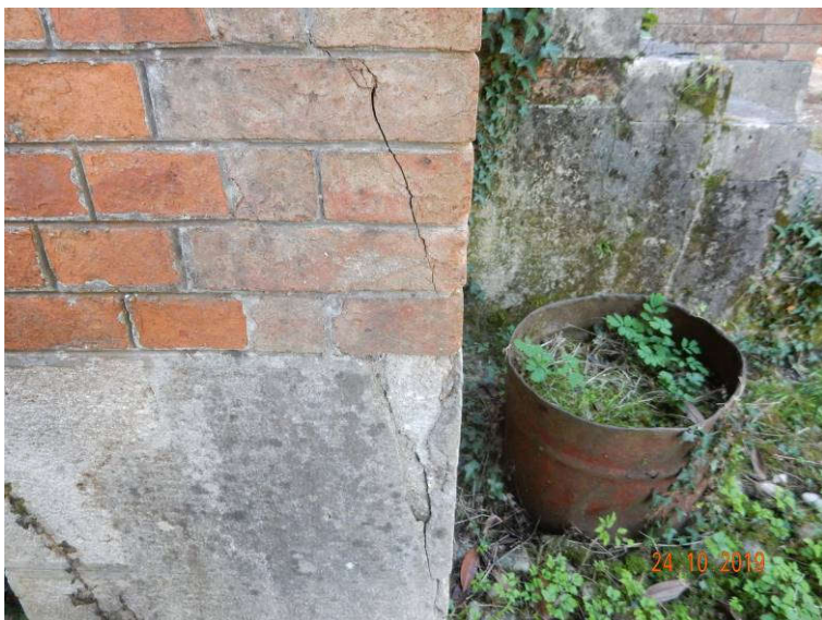
Slika 72: Vhodni objekt, poškodbe na severni fasadi: lokalne razpoke na zidu
