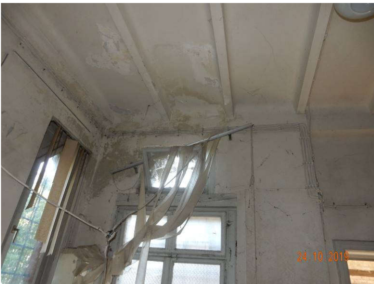
Slika 83: Vhodni objekt, poškodbe v notranjosti: odpadanje ometa, zamakanje v območju okenske odprtine
