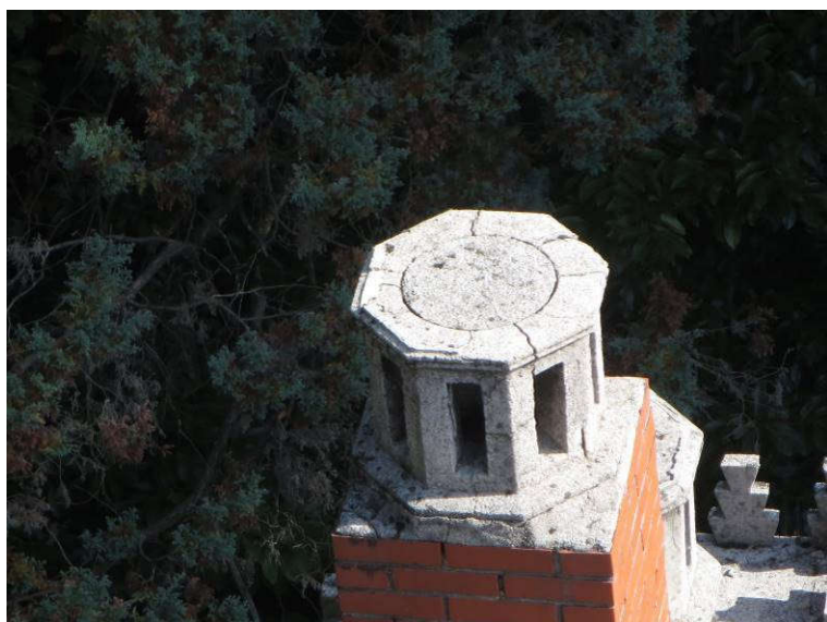
Slika 49: Poškodbe na strehi: razpoke na betonskem tamburju
