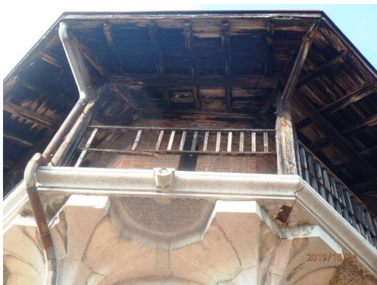
Slika 62: Poškodbe na fasadi stolpa: razpoke na betonskih konzolnih elementih, vidne tudi poškodbe elementov ostrešja
