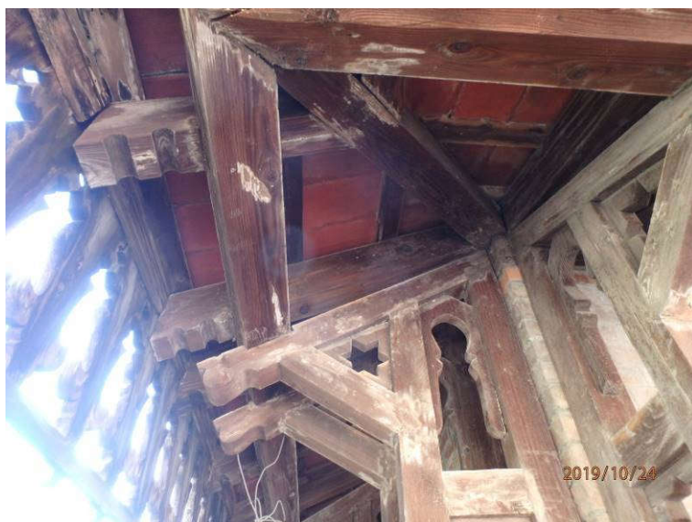
Slika 87: Vhodni objekt, poškodbe na strehi: dotrajani leseni elementi ostrešja
