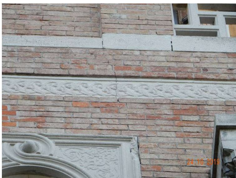
Slika 13: Poškodbe na zahodni fasadi: vertikalna razpoka med okenskima odprtinama
