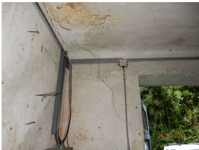
Slika 98: Garaža, poškodbe v notranjosti: razpoke na stiku strop-stena, poševna razpoka na steni
