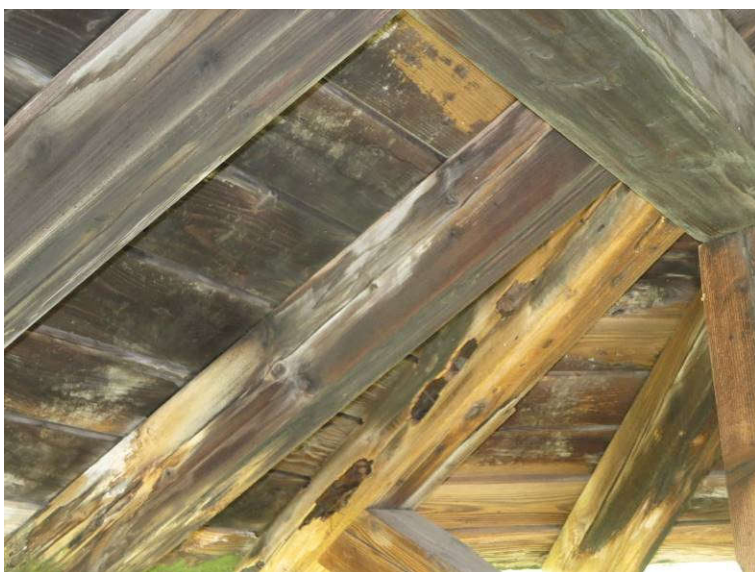
Slika 59: Poškodbe na strehi: poškodovani leseni elementi napušča (stolp)
