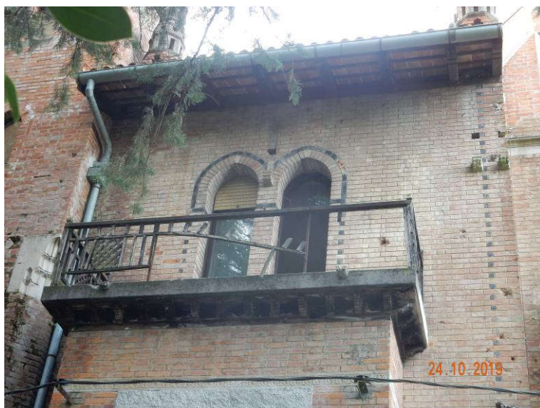
Slika 8: Poškodbe na severni fasadi: povsem uničena lesena balkonska ograja, lokalne poškodbe opečnih zidakov
