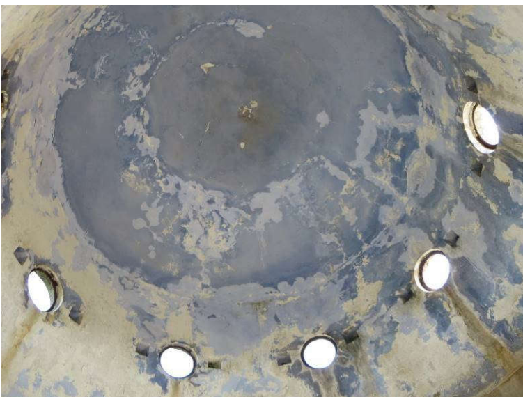
Slika 68: Poškodbe v notranjosti stolpa: odpadanje ometa in opleska v območju kupole, zamakanje skozi okenske odprtine
