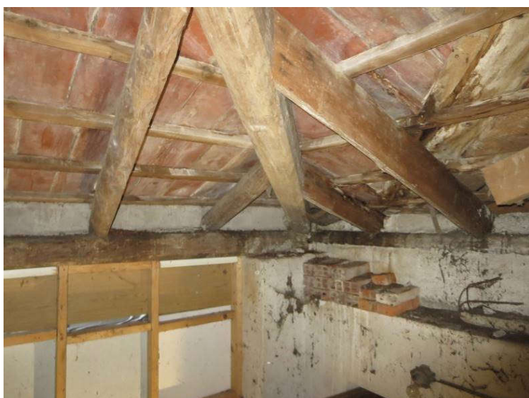
Slika 100: Garaža, poškodbe strehe: poškodbe lesenih elementov ostrešja v območju zamakanja (stari del)
