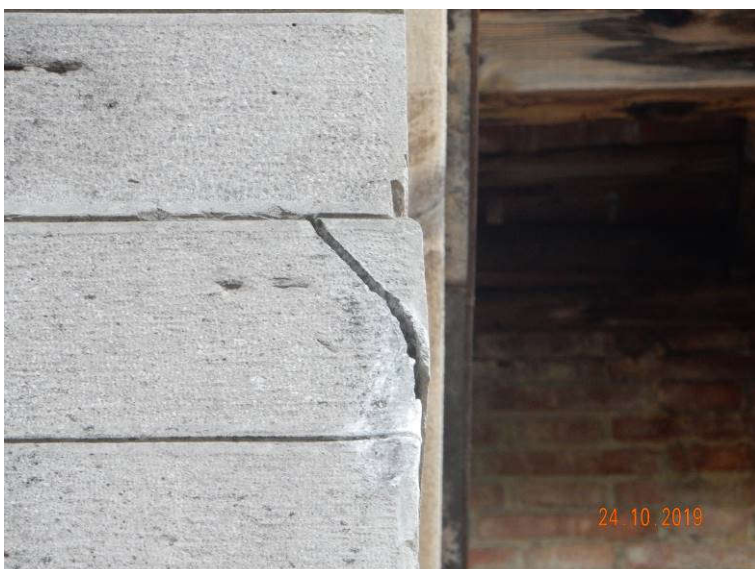
Slika 16: Poškodbe na zahodni fasadi: odlom vogala betonske fasadne obloge
