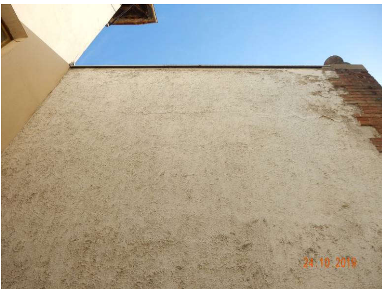
Slika 77: Vhodni objekt, poškodbe na zahodni fasadi: horizontalna razpoka na zidu
