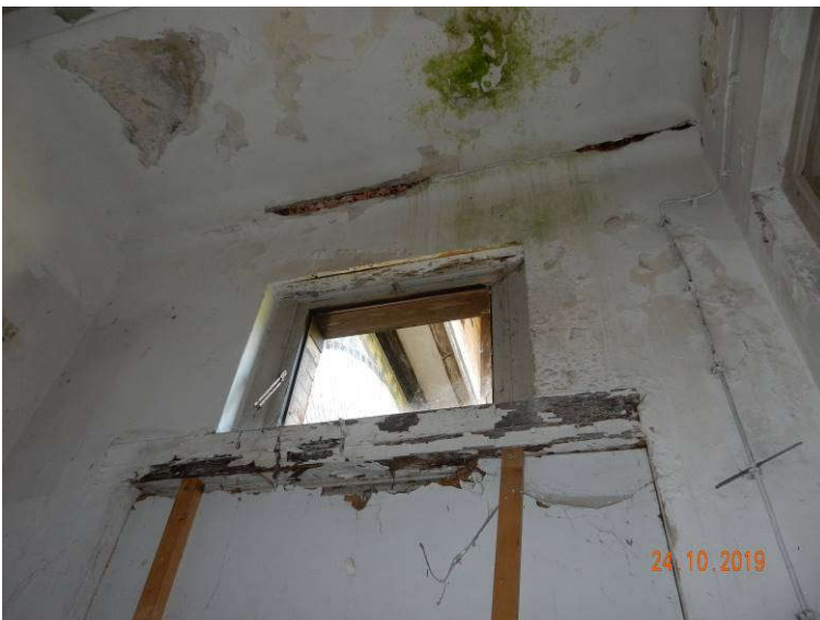
Slika 82: Vhodni objekt, poškodbe v notranjosti: odpadanje ometa, korozija jeklenega nosilca, zamakanje skozi strop, zamakanje v območju okenske odprtine
