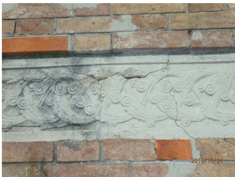
Slika 61: Poškodbe na fasadi stolpa: razpadanje betonske obloge venca in korozija armature
