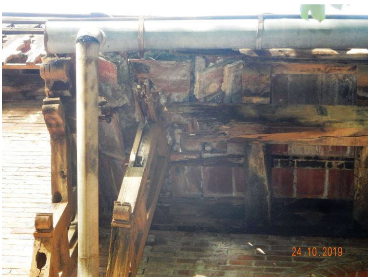
Slika 25: Poškodbe na vzhodni fasadi: močno poškodovani leseni elementi napušča – možnost porušitve
