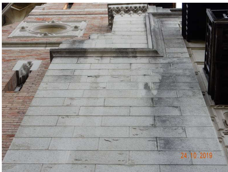
Slika 14: Poškodbe na zahodni fasadi: luščenje krovnega sloja betona fasadne obloge in korozija armature
