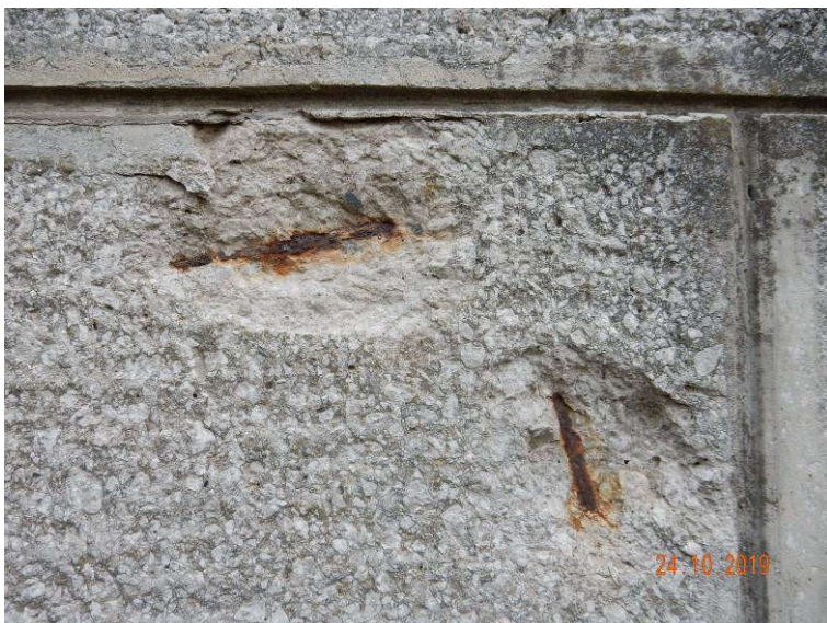
Slika 15: Poškodbe na zahodni fasadi: luščenje krovnega sloja betona fasadne obloge in korozija armature
