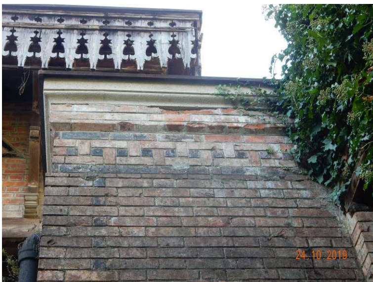
Slika 74: Vhodni objekt, poškodbe na severni fasadi: lokalne poškodbe opečne pozidave
