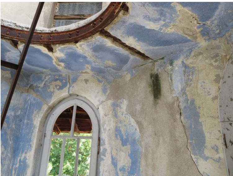
Slika 67: Poškodbe v notranjosti stolpa: razpadanje betona in korozija jeklenih elementov konstrukcije podestov, vertikalna razpoka na steni
