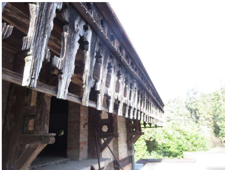
Slika 86: Vhodni objekt, poškodbe na strehi: dotrajani leseni okrasni elementi napušča
