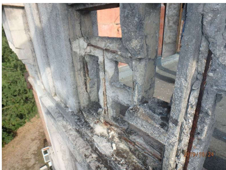
Slika 46: Poškodbe na strehi: razpadanje betonske ograje
