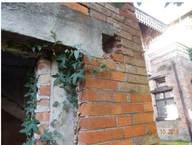
Slika 73: Vhodni objekt, poškodbe na severni fasadi: lokalne poškodbe opečne pozidave
