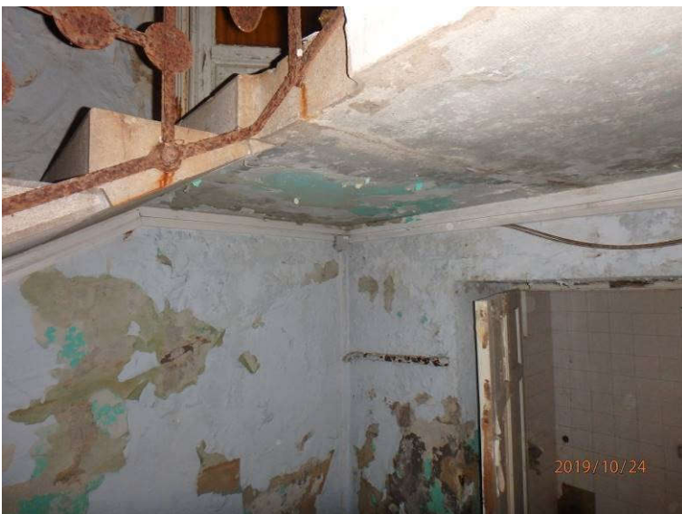
Slika 28: Poškodbe v notranjosti kleti: odpadanje ometa in luščenje opleska, prekomerna vlaga
