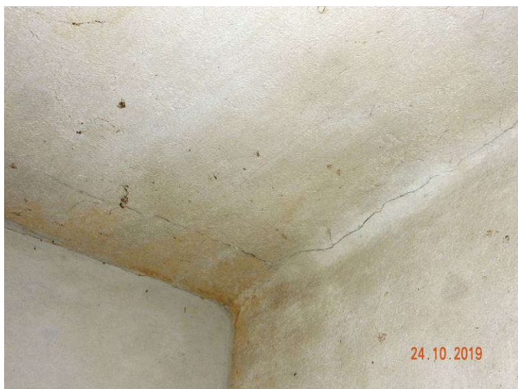
Slika 97: Garaža, poškodbe v notranjosti: razpoke na stiku strop-stena
