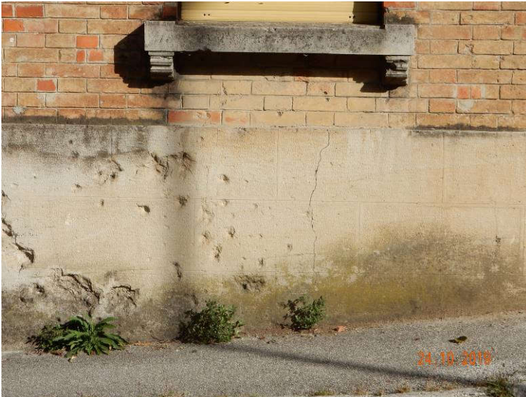
Slika 75: Vhodni objekt, poškodbe na južni fasadi: vertikalna razpoka in odpadanje krovnege sloja betona na coklu
